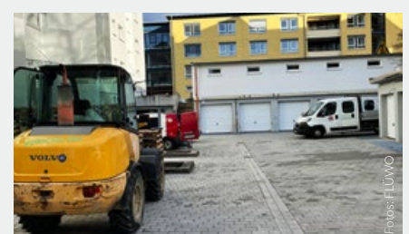
Karlsruhe, Hertzstraße, Hofsanierung
